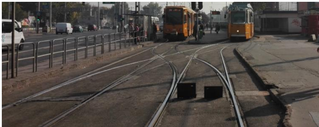
8. ábra: A szolgálati hely bejárati váltói
