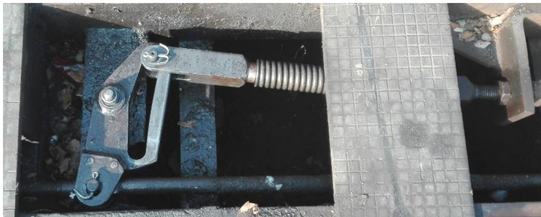
7. ábra: A visszahegesztett kulissza szerkezet későbbi felvétele
