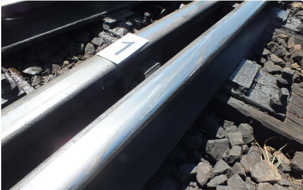
11. ábra: átugrasi nyomok a főirányból mellékirányba terelő csúcssínen
