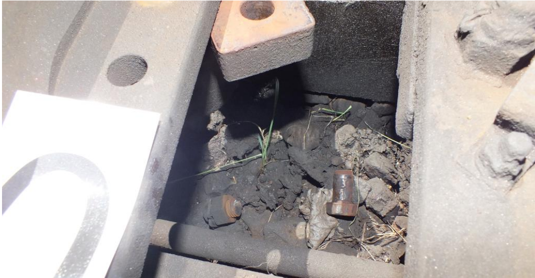
5. ábra: csavartöredékek az ágyzatban
