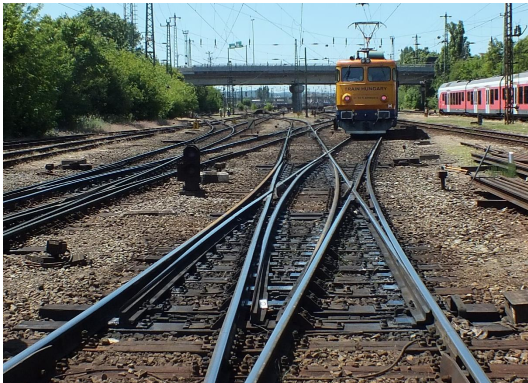
3. ábra: az eseményben érintett átszelési kitérő és a mozdony a nem tervezett irányban, sínen
