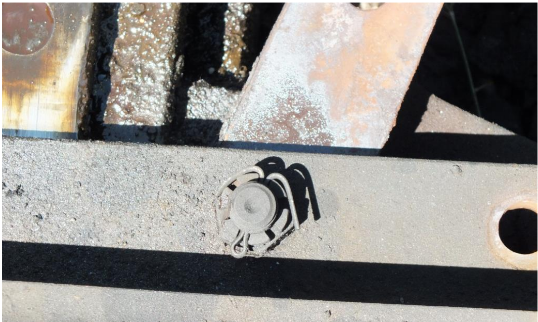
8. ábra: a csúcssínfűl másik, laza rögzítőcsavarja
