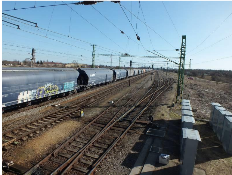
5. ábra: A kiegészítő kapcsolószekrények
