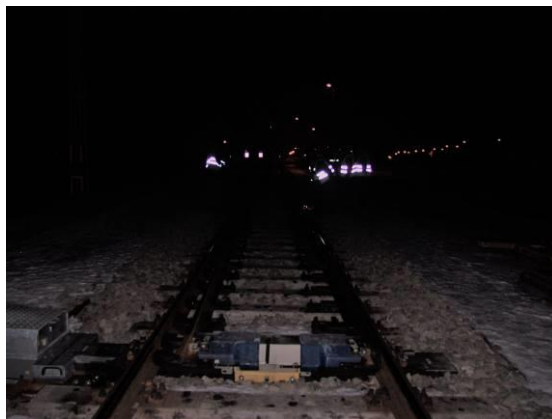
6. ábra: A kitérő irányba átvált 2 sz. váltó
