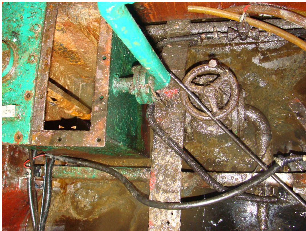
8. ábra: A vízszekrény és a tolózár együttese
