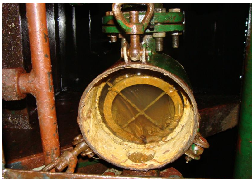
5. ábra: A vízsűrő-ház a szűrőbetéttel, zárófedél nélkül.
