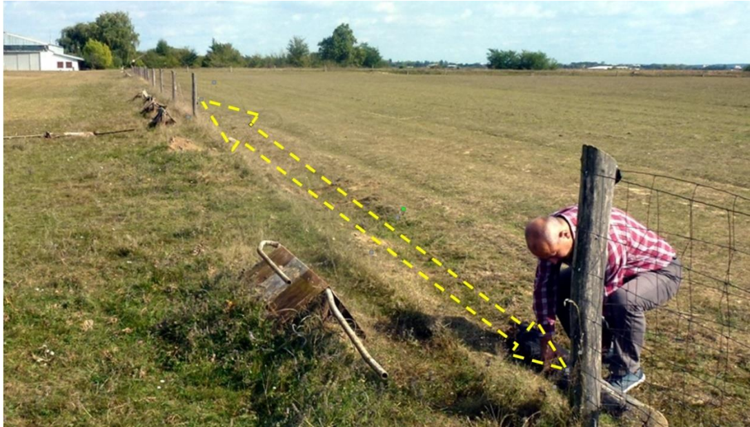
6 ábra a megrongálódott kerítés-szakasz
