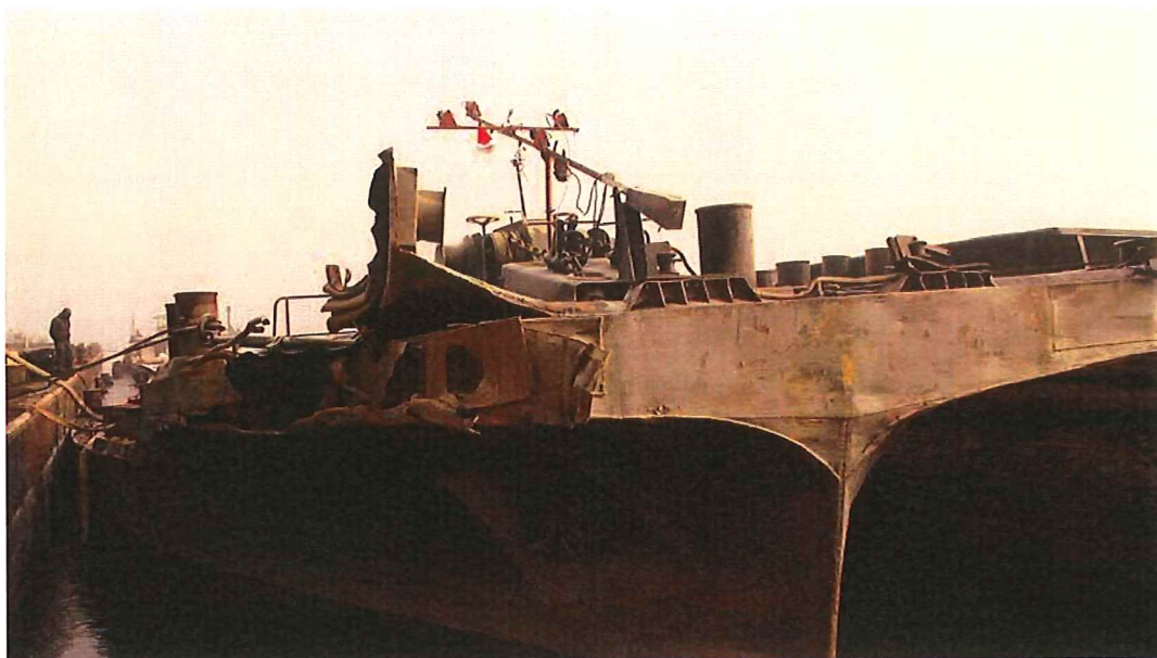
10. ábra: Az uszály jobb oldalát ért károsodás (Fotó: NKH)
