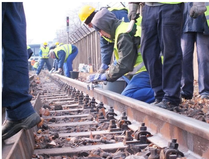
19. ábra: Kézi csúszásmentesítés (a helyszíni szemle során készült felvétel)
