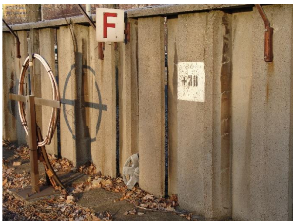
9. ábra: A pálya zártságát biztosító betonkerítés
