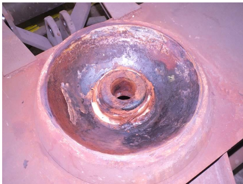
8. ábra: A berzsdásodott forgótányér
