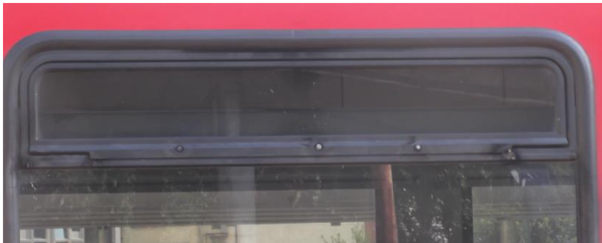
4. ábra: a villamos szempontból elszigetelt ablakkeret külső károsodásai
