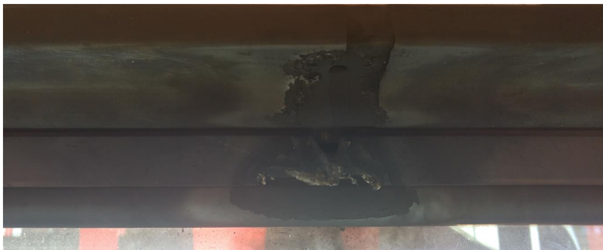
5. ábra: a megolvasztott ablakkeret és az átégetett ragasztó
