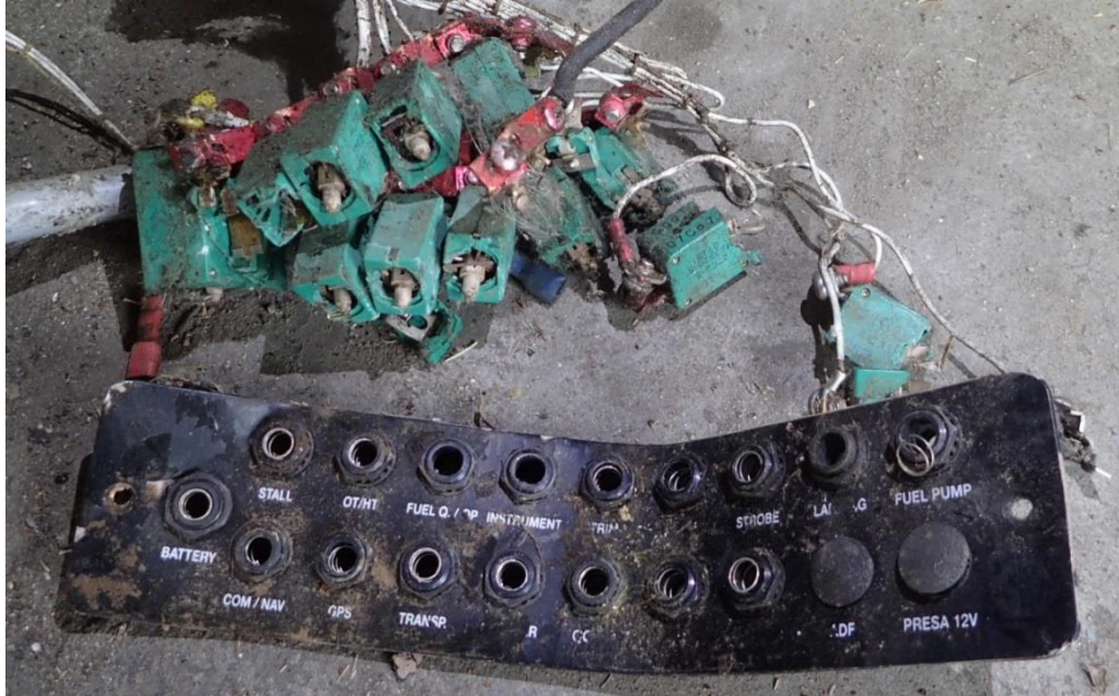
8. ábra: a megrongálódott CB panel
