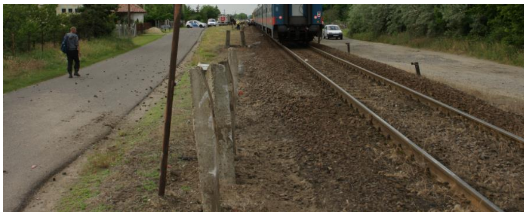
10. ábra: A baleset nyomai a beásott vasbetonaljakon
