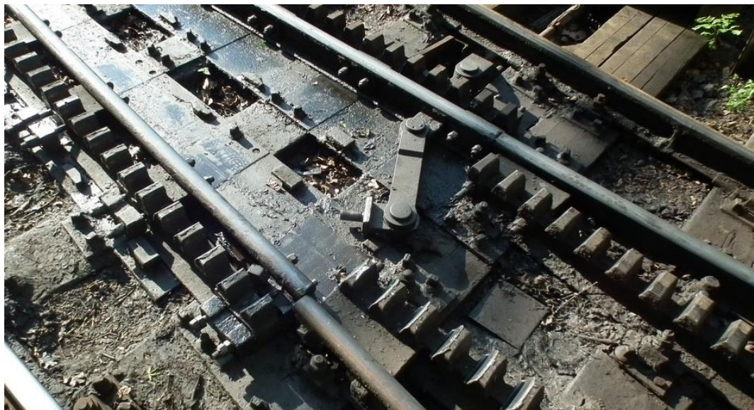
7. ábra: a szétesett összekötő rúd
