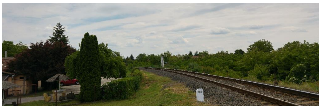
7. ábra: Rálátás a vasúti pályára a 100 sz. szelvényben lévő útátjáróból nézve.
