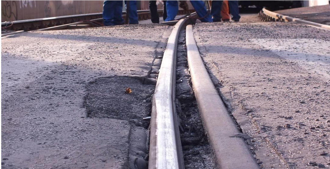
9. ábra: irányhiba a bal sínszálban
