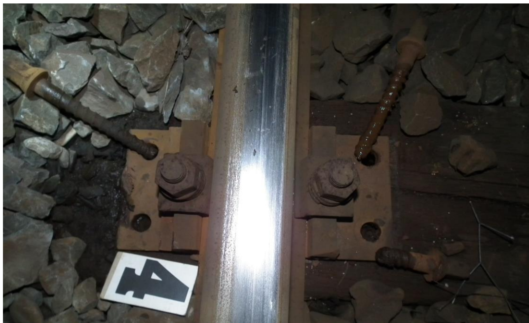
3. ábra: kézzel kihúzott, törött, vizes csavarok
