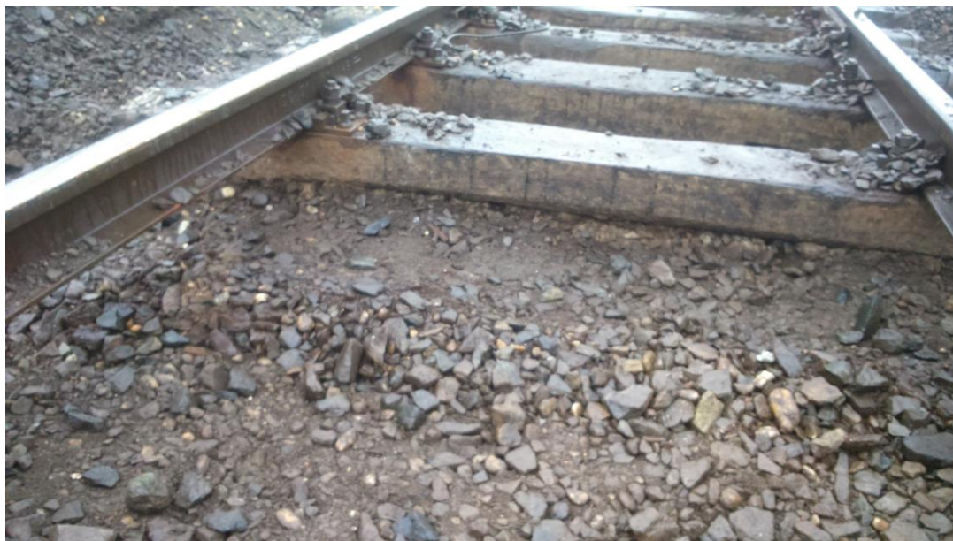
4. ábra: az ágyazat a kisklás helyén, az aljcsere idején (fotó: GySEV Zrt.)
