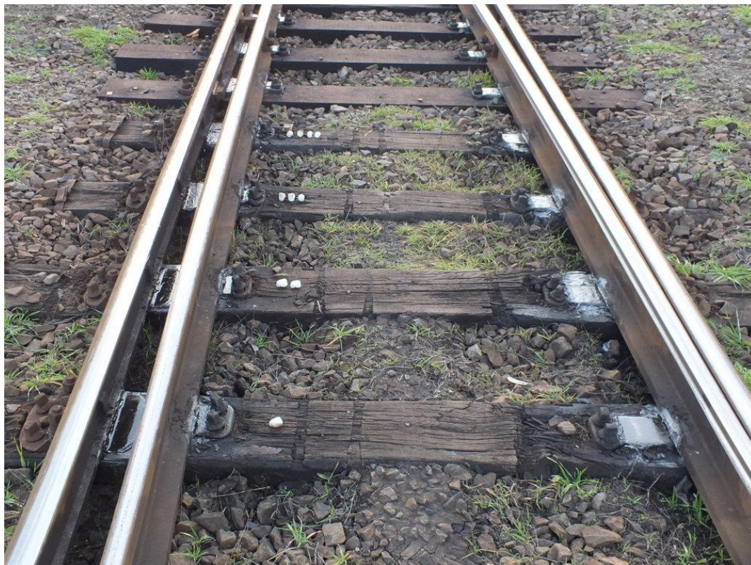
6. ábra: a 451. sz. kitérő alj-állaga a kisiklás környezetében (a kisiklás helye a két jelel ellátott alj bal sínzálánál van)
