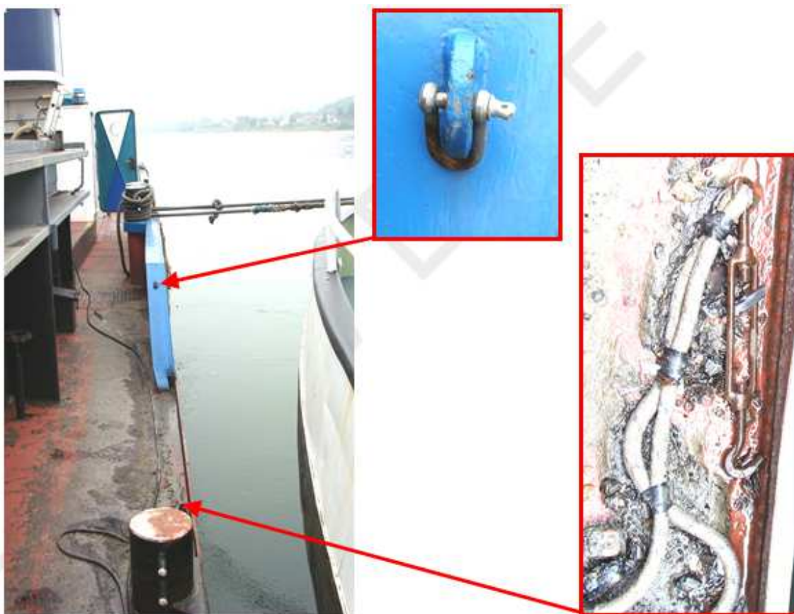
3. ábra: a védőkoriát leszerelt kötélzete a vízbe esés helyén
