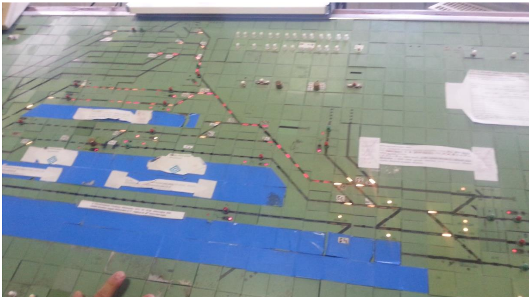
12. ábra: a D55 kezelőpultja; a képen látható fények többsége villog
