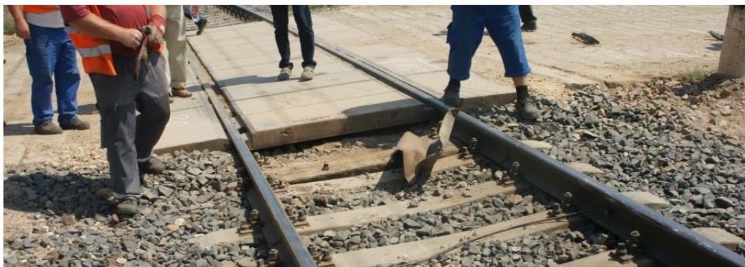
4. ábra: A megsérült útátjáró elemek
