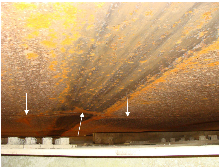
8. ábra: a fenéklemez benyomódásának mértéke a lemezillesztés vonalában
