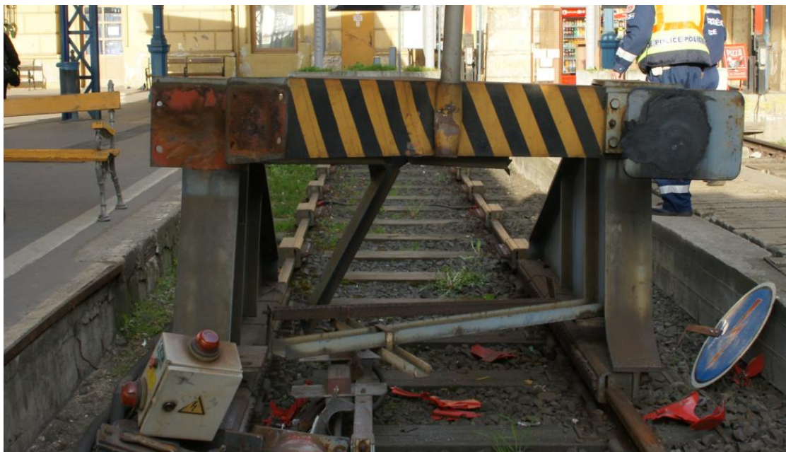
5. ábra: Az ütközőbak sérülései
