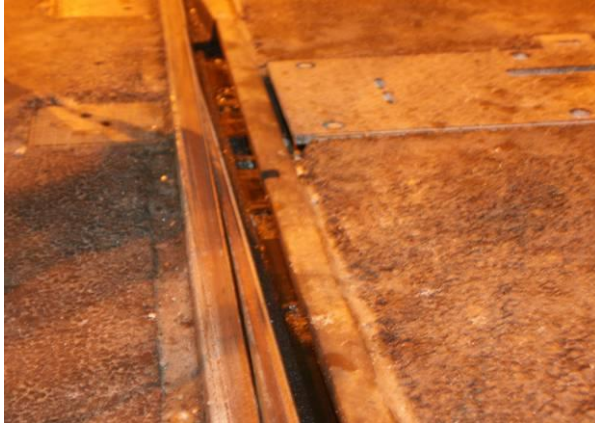
6. ábra: A visszahúzást követően kitérő állásban maradt váltó.
