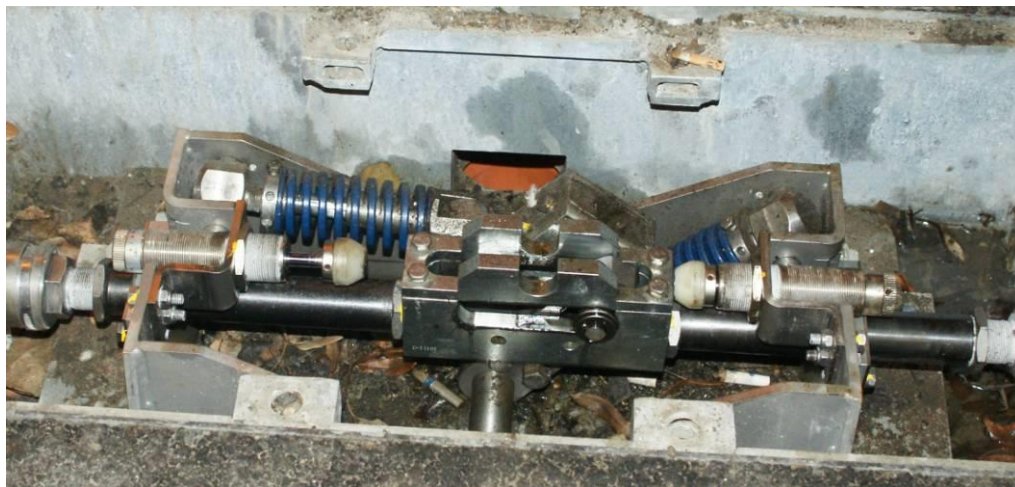
3. ábra: A K3001 sz. kitérő állító szerkezete
