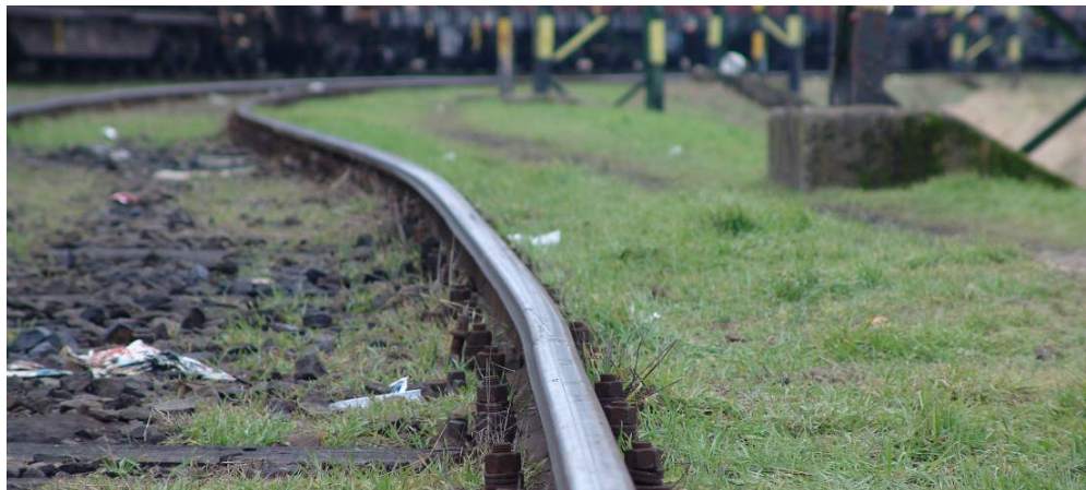
4. ábra: a sínszál torzultsága az esemény után (menetiránnyal ellentétesen nézve)
