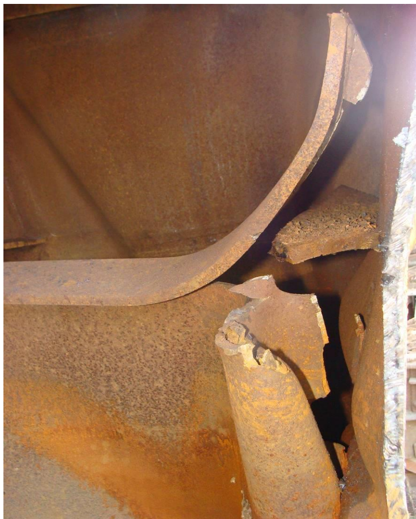
10. sz. ábra: A sérült bordázat
