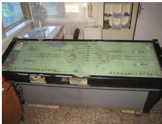
9. ábra: A biztosítóberendezés kezelőpultja
