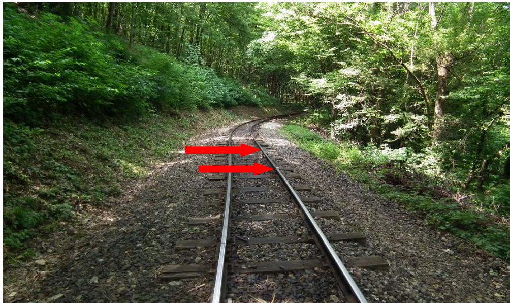
5. ábra: az kisiklás helye a 31. szelvényben (felkapás és leesés), a vonat menetirányában fényképezve
