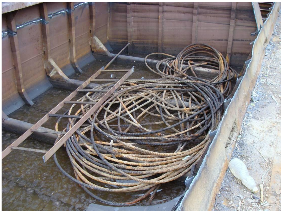
4. sz. ábra: Korrodált acélsodrony kikötőkötél
