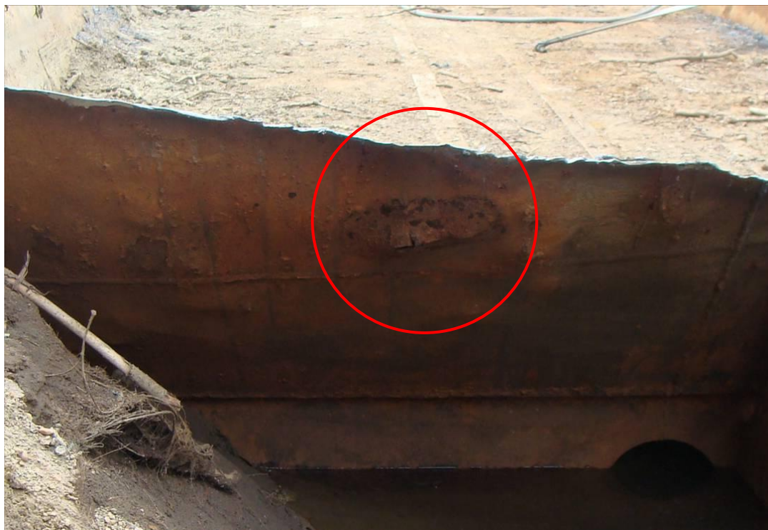
9. sz. ábra: A raktér homloklemezén talált sérülés
