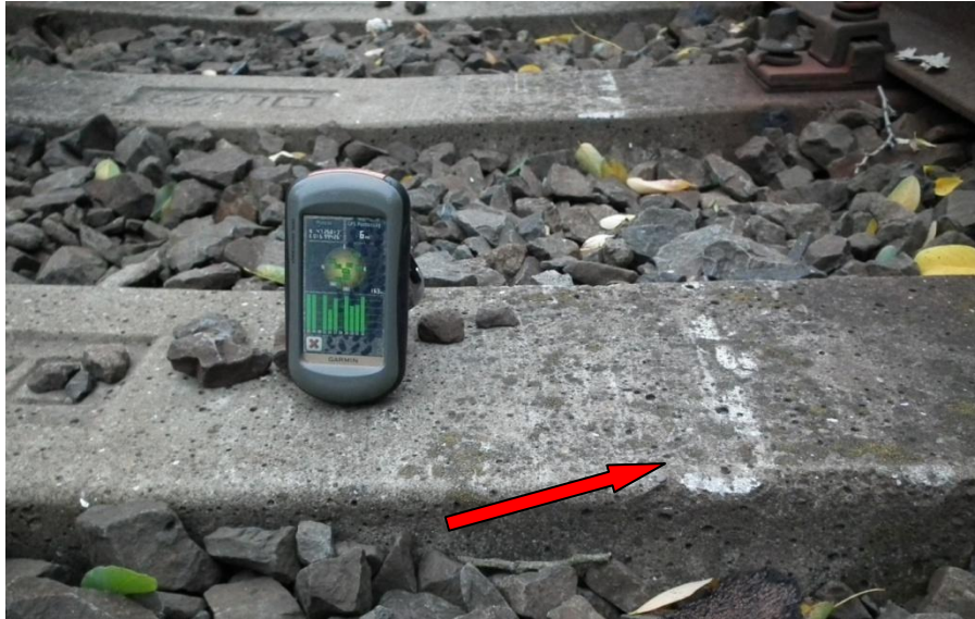
6. ábra A fedél súrlódási nyoma egy betonajlon
