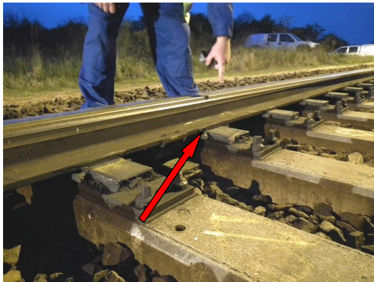
10. ábra Ütési nyomok a csúcssín belső oldalán
