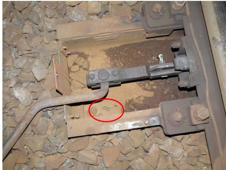
11. sz. ábra A zárszerkezet rugója a váltó zárnyelv-dobozában
