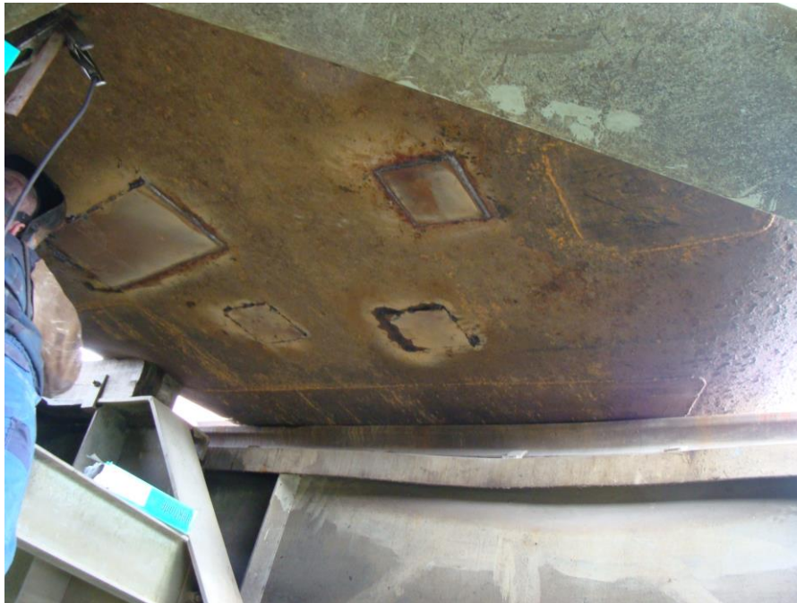
6. kép: Lemezjavítások az uszály fenékrészén
