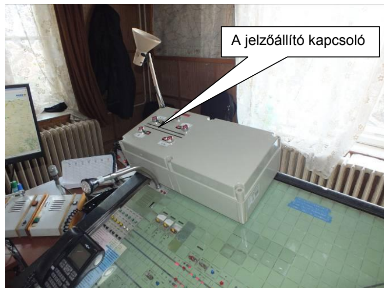
4. ábra: A biztosítóberendezés kezelőpultja és a jelzőállító kapcsolók
