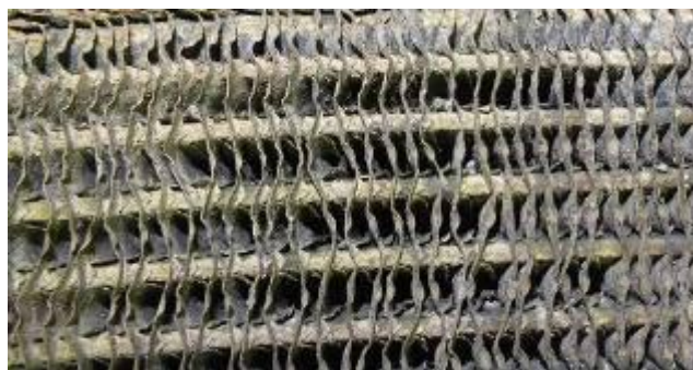
10. ábra: A megsérült olajhűtő-panel
