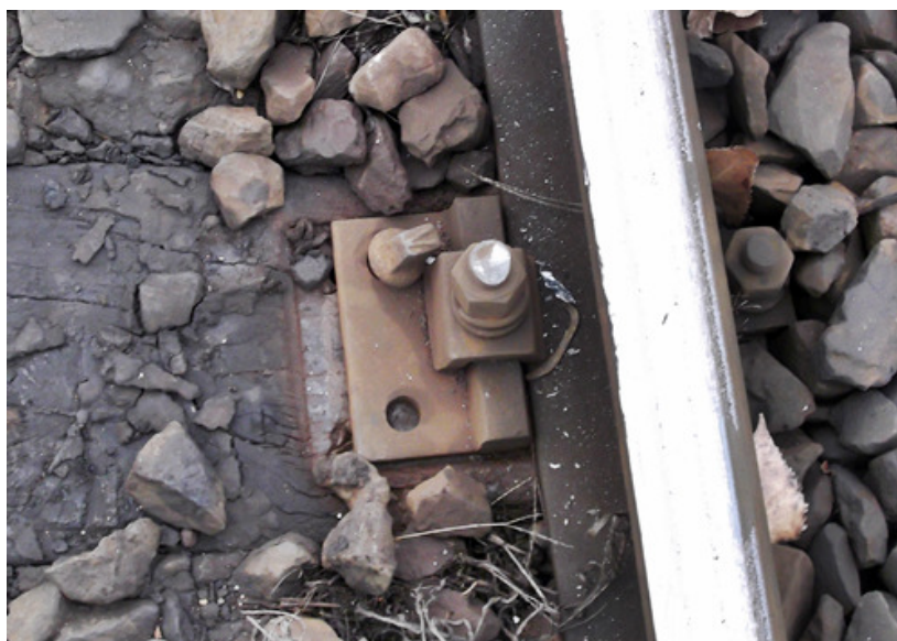
5. ábra: Siklási és rugalmas nyombővülési nyomok az eset helyszínén (Forrás: MÁV Zrt.)
