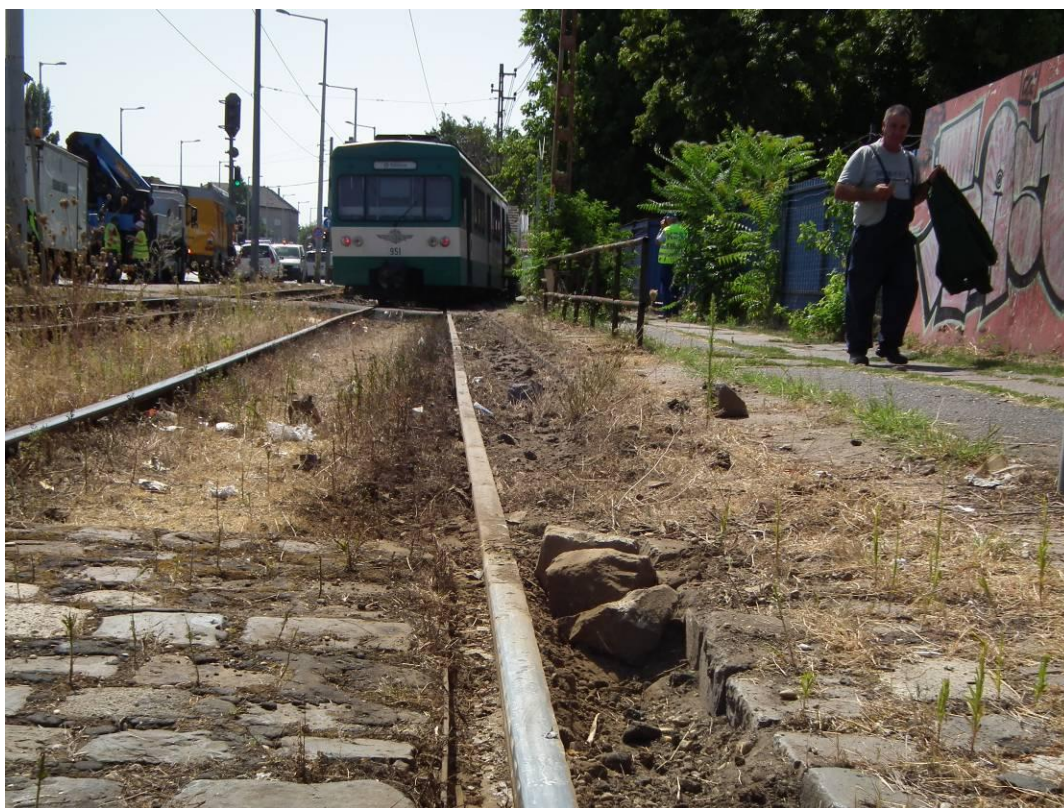
3. ábra: a kisiklott szerelvény és a kisiklás nyomai
