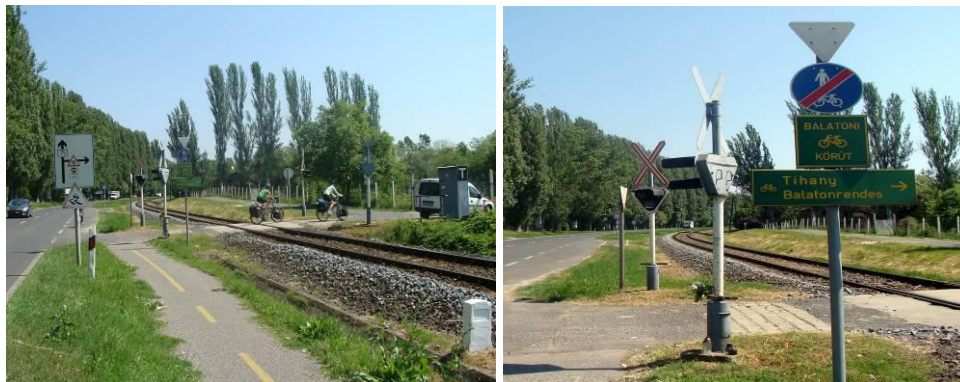
7. ábra: a kerékpárútról a fényjelző készülék láthatósága I.
