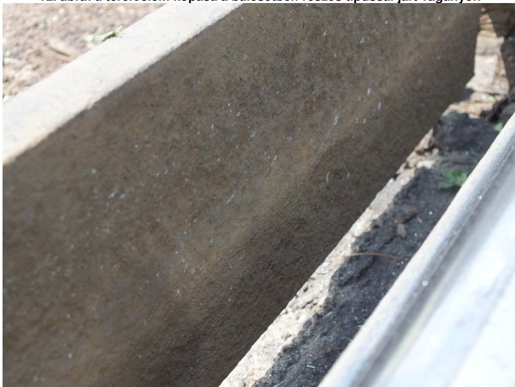
13. ábra: terelőelem a balesetben részes típusal nem járt vágányon
