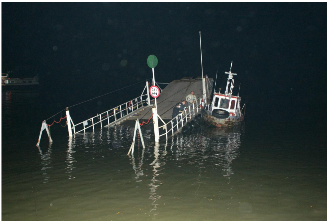
1. sz. ábra: A részlegesen elsüllyedt komp
