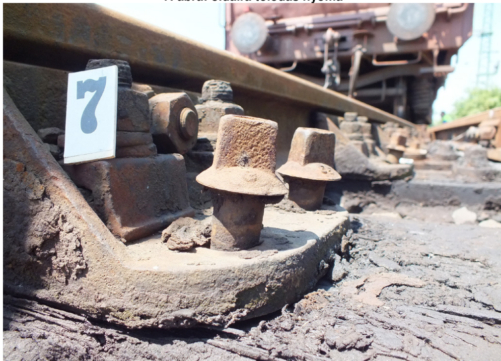
8. ábra: laza kapcsolószerek, szennyeződés a csavarok alatt
