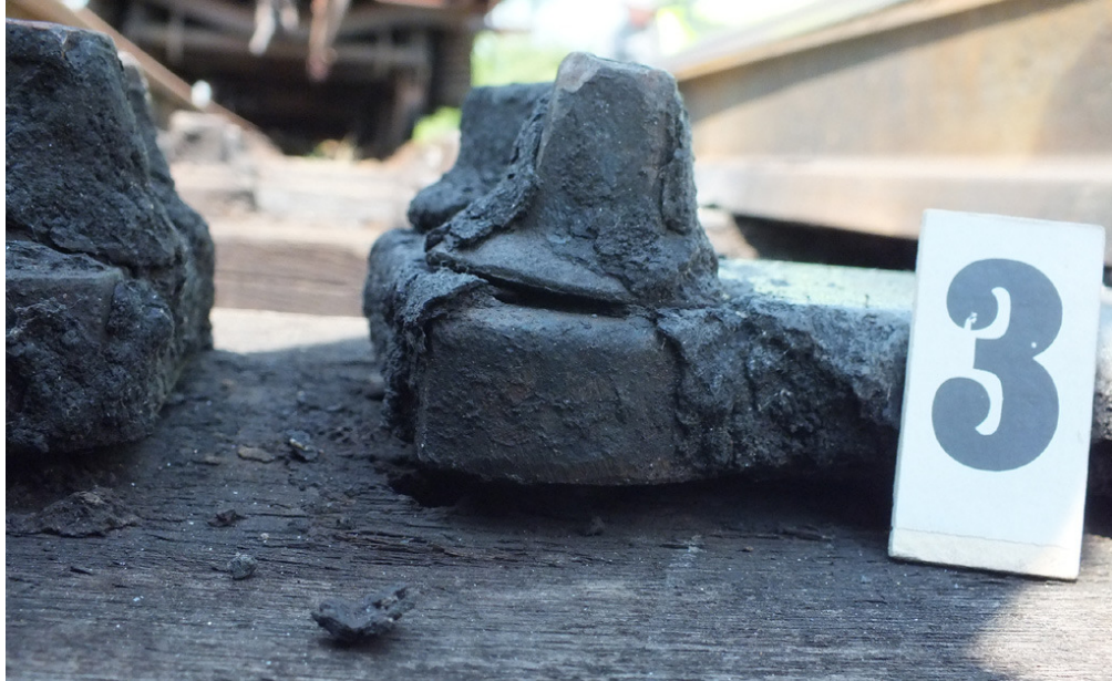
9. ábra: laza kapcsolószerek, szennyeződés a csavarok alatt
