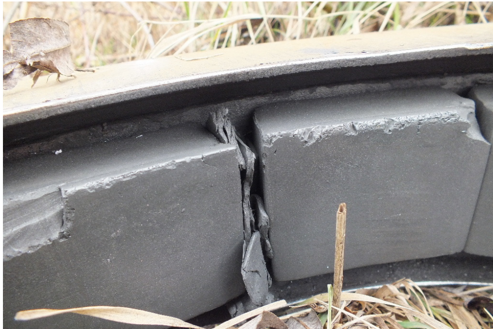
8. ábra: gumiszalag a gumirugók között (helyszíni felvétel)
