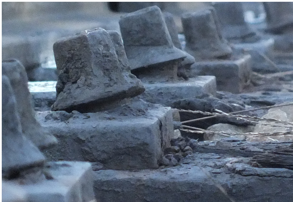
19. ábra: megdőlt csavarok, szennyeződve
