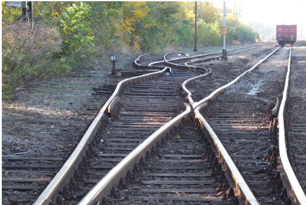
4. ábra: a megrongálódott váltóközet
