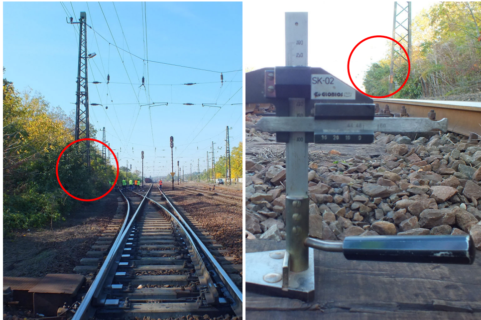
21. ábra: felsővezeték-oszlop, lassúmenet jelző nélkül
