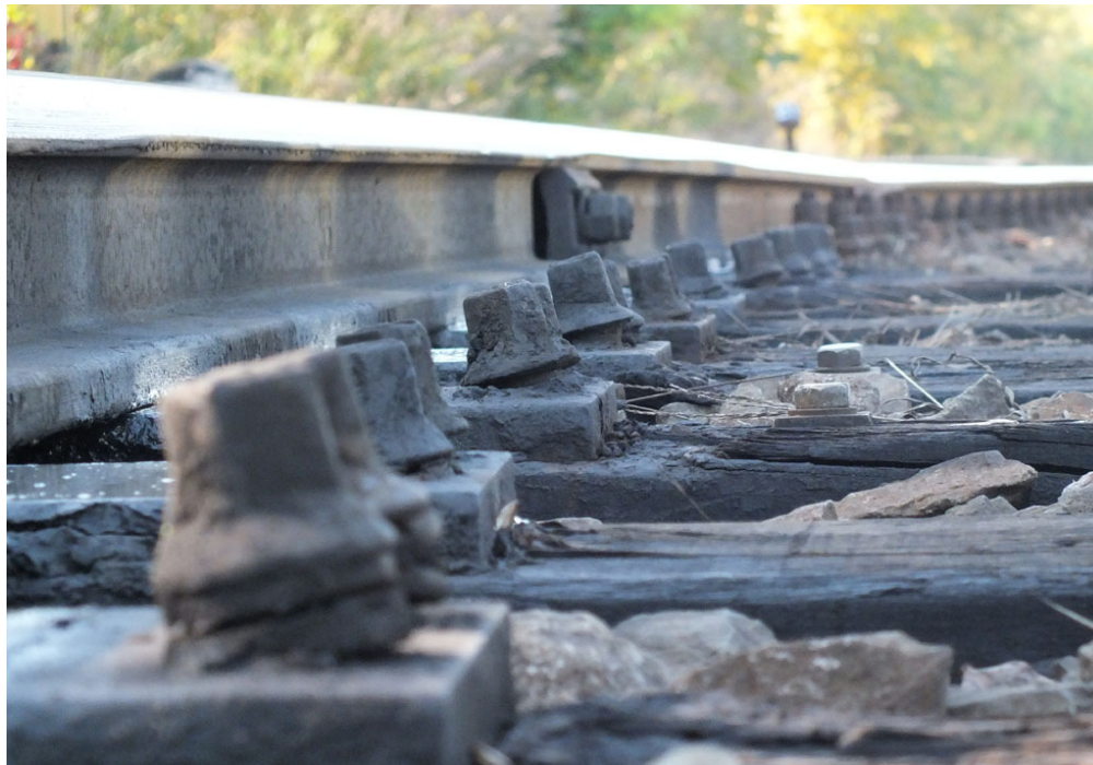
8. ábra: oldalra dőlt csavarok
