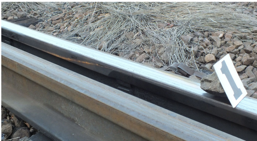
12. ábra: a közézéses jellegzetes nyoma
