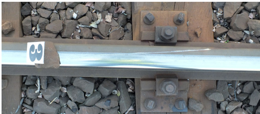
14. ábra: felkapási nyom
