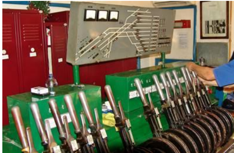
3. ábra: Az SH biztosítóberendezés a szolgálati hely II. sz. ór helyén
