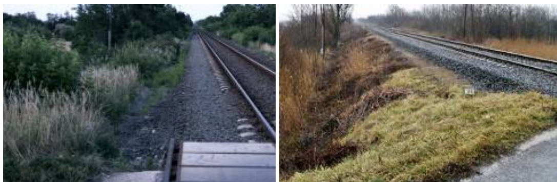
6. ábra: A szintbeli kereszteződés beláthatósága az eset napján és a növényzet ritkítása után
