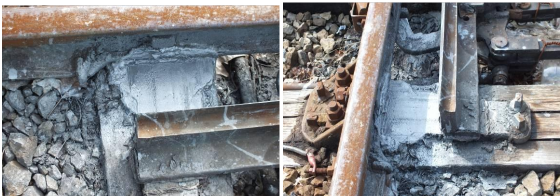
5.sz.ábra:a váltó alkatrészein felrakódott kenőanyag
