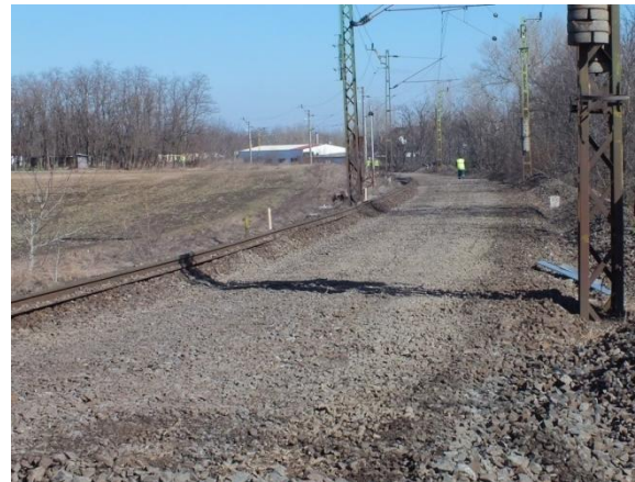
5. sz. ábra A vasúti pálya újjáépítése
