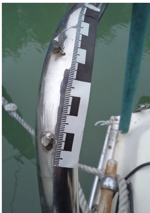
4. ábra: a jobb oldali törött rögzítőelem
