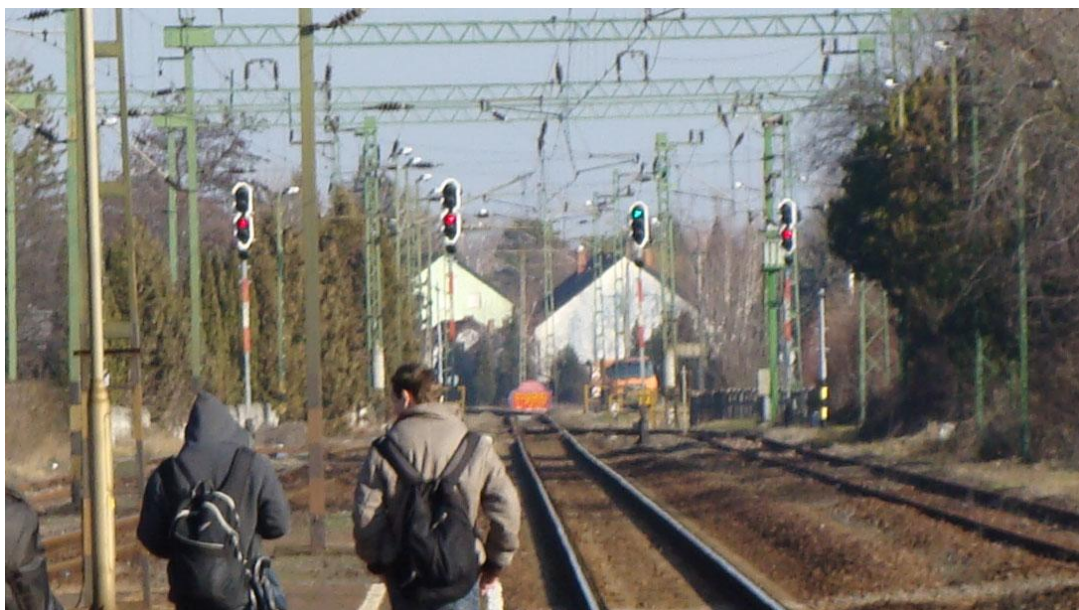
6. sz. ábra: A „K3” jelű kijáratú jelző továbbhaladást engedélyező szinképe
