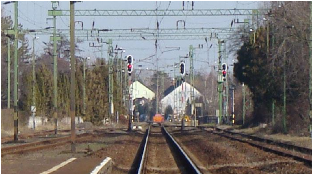
4. sz. ábra: A „K3” jelű kijárat jelző fővörös izzócsere előtt
