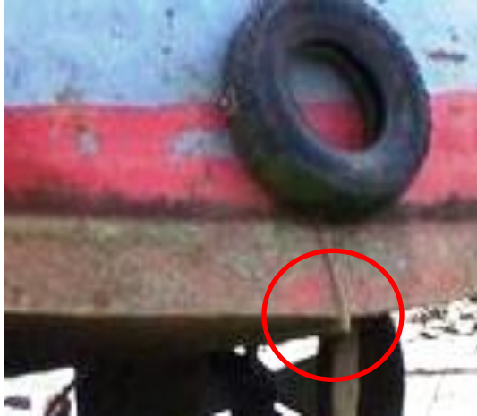
A függőleges élű merevítő borda éles sarka a vízvonal alatt.
