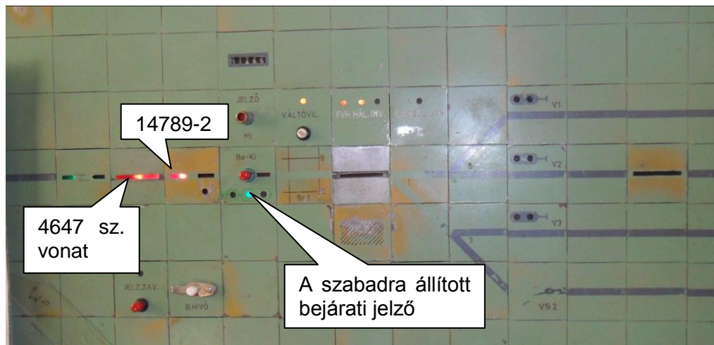
5. ábra A biztosítóberendezés visszajelentő fényei (a helyszíni szemle során készített felvétel)
