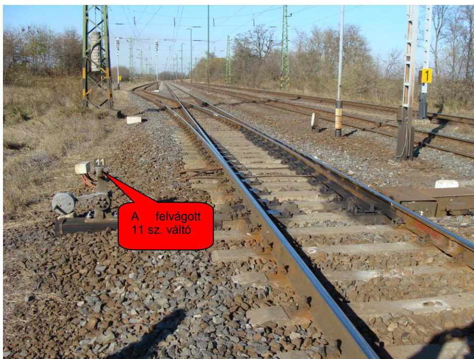
3.sz. ábra: a felvágott 11. sz. váltó
